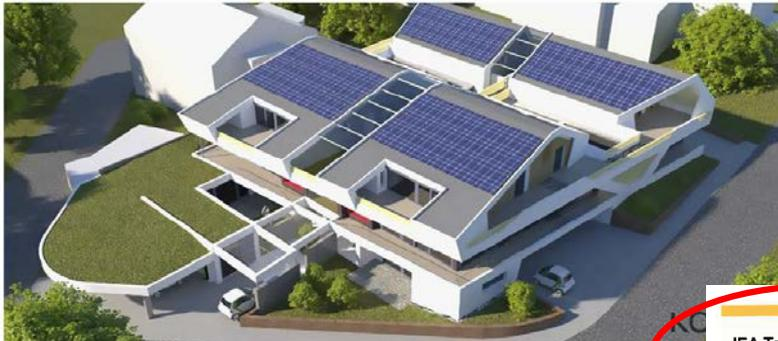
Wohnanlage in Weinstadt: Eine Sole-Wasser-Wärmepumpe, ein Eisspeicher und PVT-Kollektoren nutzen effizient Solarstrahlung und Umweltwärme.
