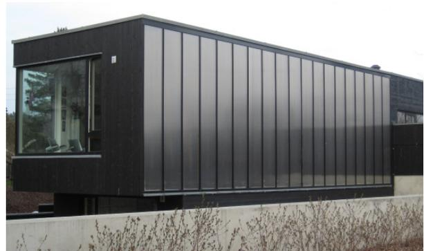
**Abbildung 6: Schnitt durch den Solarnor Kollektor (links [2]) und fassadenintegrierte Solarnor-Anlage in Oslo (rechts; Foto: FH Ingolstadt)**
