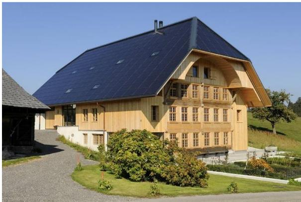
Figure 79: Glaserhaus Affoltern im Emmental (CH). Photovoltaic roof, © C. Heilig
