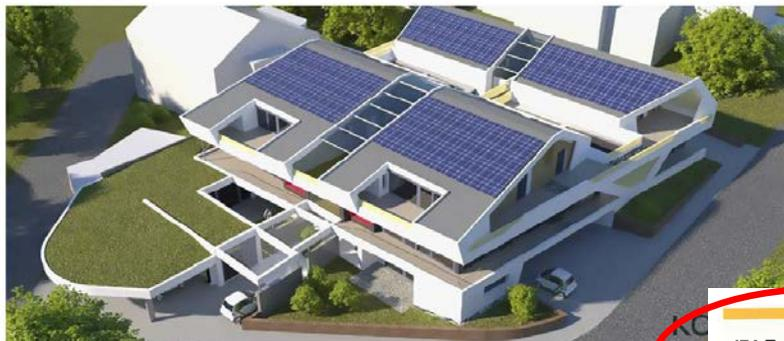
Wohnanlage in Weinstadt: Eine Sole-Wasser-Wärmepumpe, ein Eisspeicher und PVT-Kollektoren nutzen effizient Solarstrahlung und Umweltwärme.
